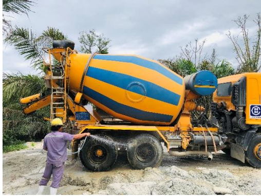
รูปที่ 5 การล้างทำความสะอาดล้อรถบรรทุก
