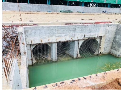
รูปที่ 15 ตะแกรงดักขยะ
