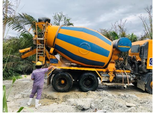
รูปที่ 5 การล้างทำความสะอาดล้อรถบรรทุก
